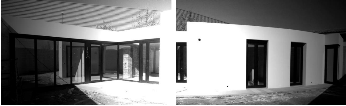
Figura 4. Fachada interior -sur-. En construcción.
